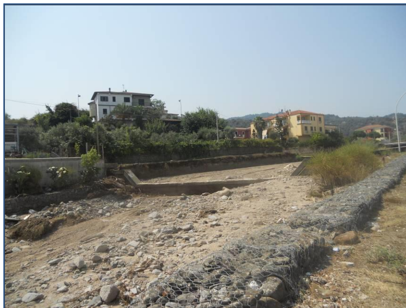
2.1.1.4 - T. Citrea, interrimento briglia e esondazione in sinistra idraulica sull'argine in gabbioni
