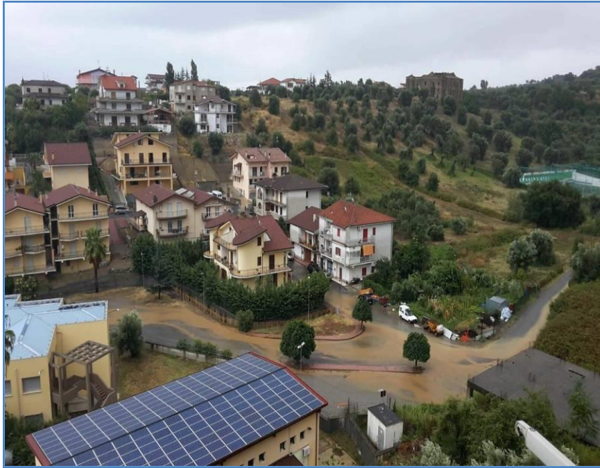
2.3.2. Allagamenti del centro urbano di Mirto di Crosia
