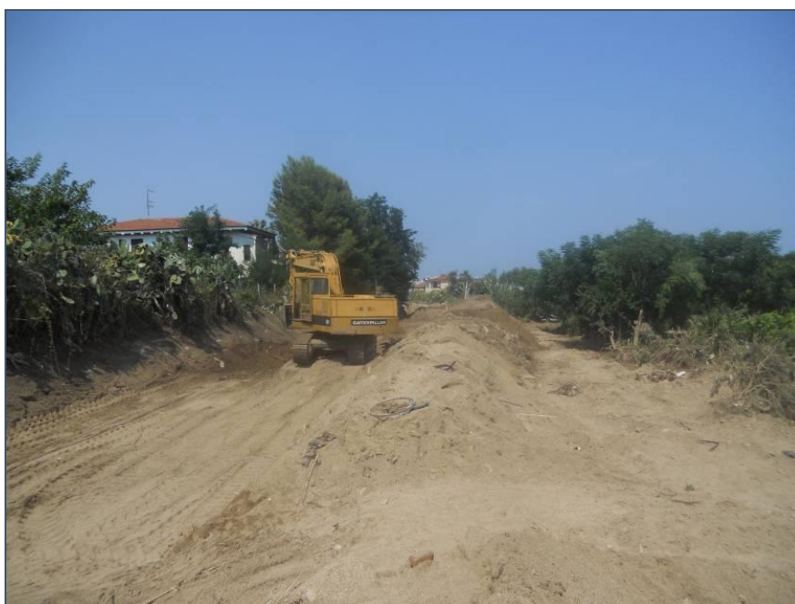
2.1.2.5- Lavori di somma urgenza sul Torrente Fellino- rimozione materiale depositato dalla piena
