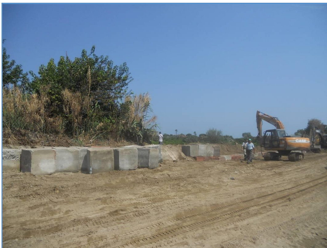
2.1.3.3 Lavori di somma urgenza a ripristino dell'argine sinistro a valle della 106
