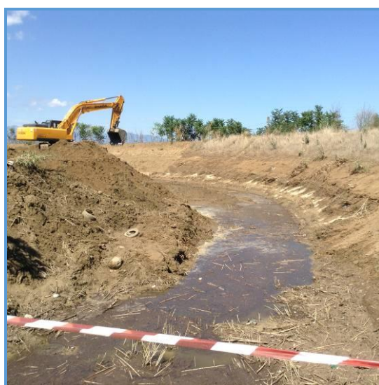
2.2.1 - Lavori in somma urgenza sul torrente Leccalardo
