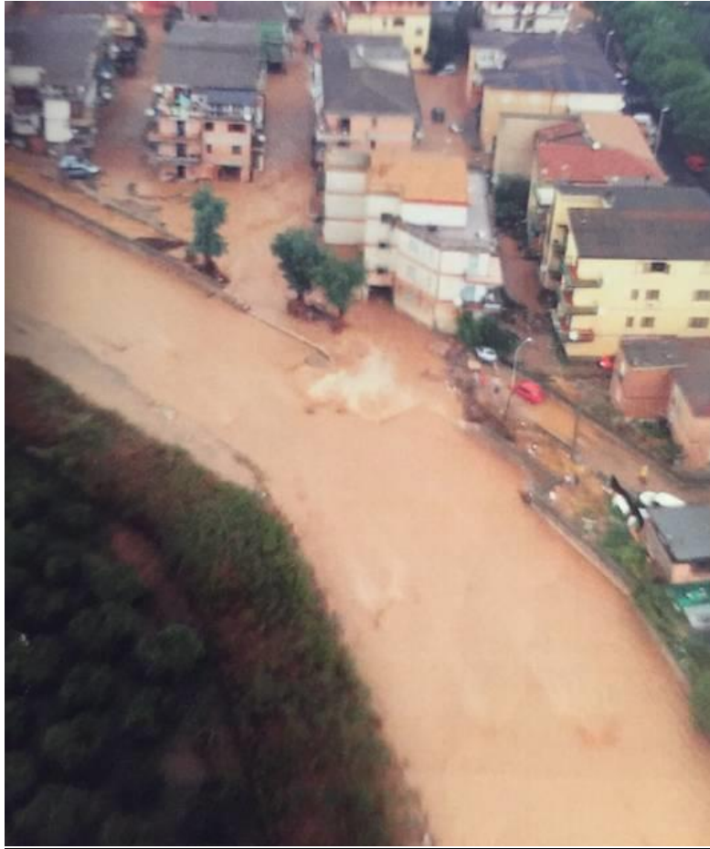
2.1.1.6 - Rotta dell'argine del Torrente Citrea in dx idraulica
