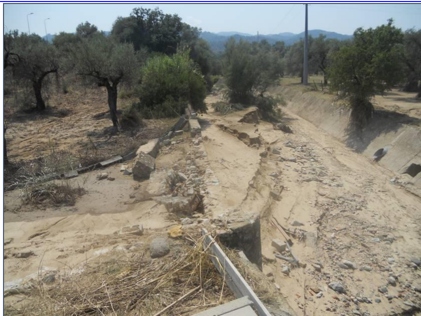
2.1.2.3 Rottura di argine in sx idraulica (T. Fellino zona monte)
