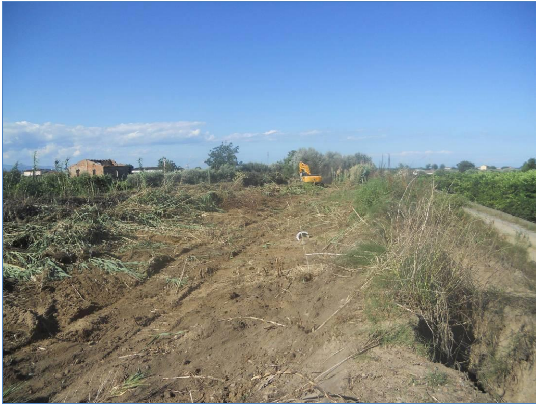
2.2.2.2 - Lavori in somma urgenza sul torrente Gennarito
