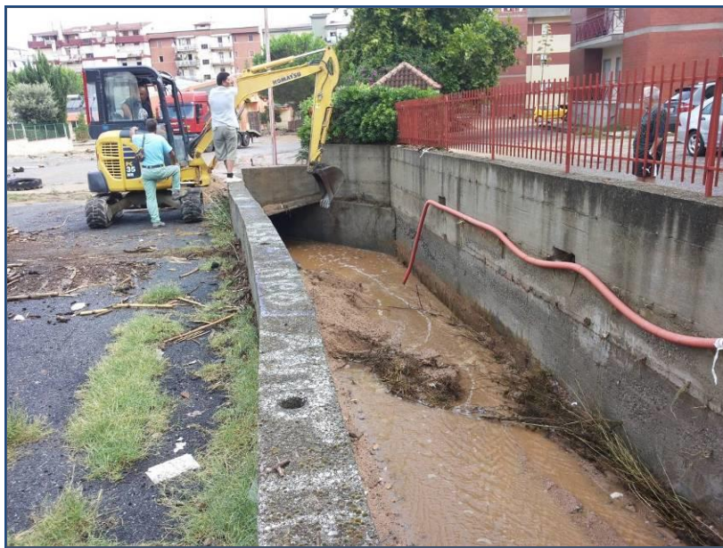
2.1.1.5 - T. Citrea, affluente T. San Paolo, in fase dei lavori di somma urgenza all'ingresso dell'intubata
